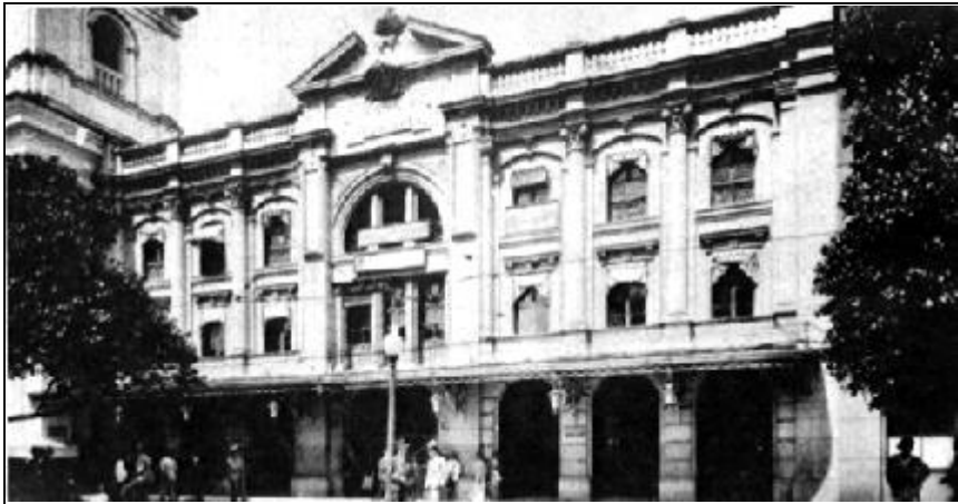
Fachada exterior del Banco de la República
