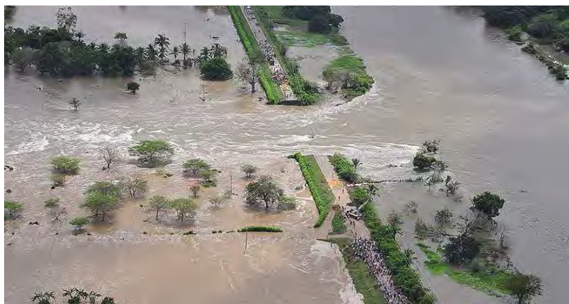
Figura 1. Ruptura del Canal del Dique en el sur del Atlántico (2010)
