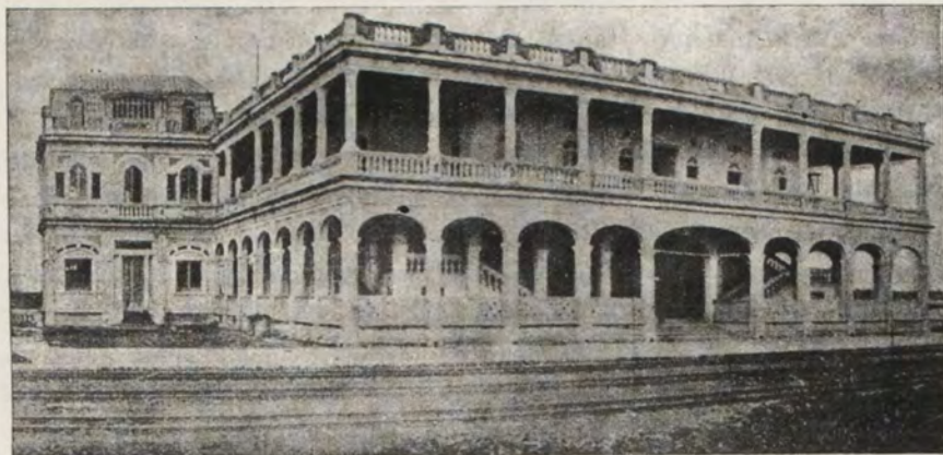
HOTEL-ESTACIÓN DEL FERROCARRIL DEL PACÍFICO, EN BUENAVENTURA
