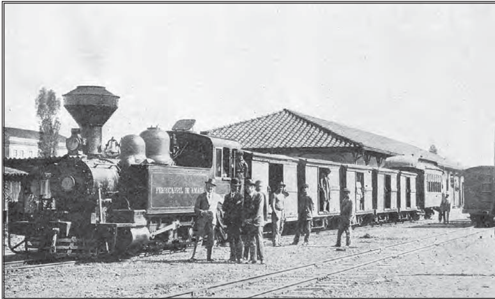
FIG. 12. ESTACIÓN DEL FERROCARRIL DE ANTIOQUIA EN MEDELLÍN
