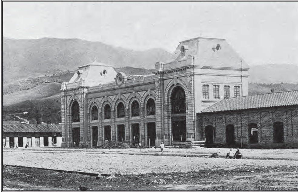
FIG. 11. ESTACIÓN DEL FERROCARRIL DE ANTIOQUIA EN MEDELLÍN
