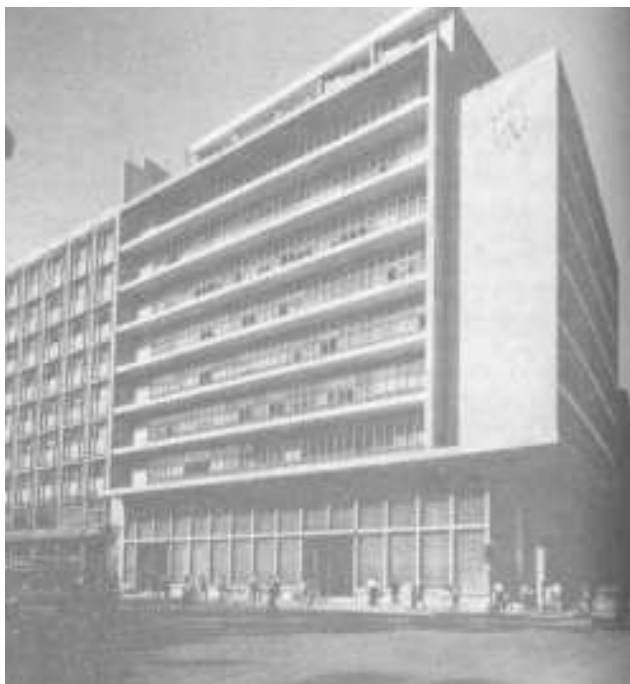
Edificio del Banco de la República situado en el costado noroccidental de la Plaza de Caicedo, donde funcionó desde mayo de 1952 hasta mayo de 1990 68
