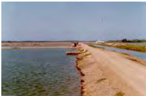
Muro perimetral de la finca C.I. Oceanos S.A.
