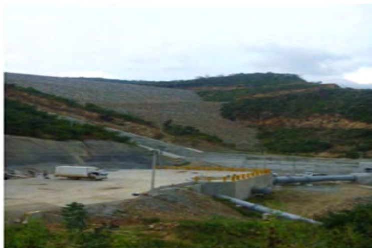
Fotografía 5. Vista de la pared de concreto de la represa El Cercado
