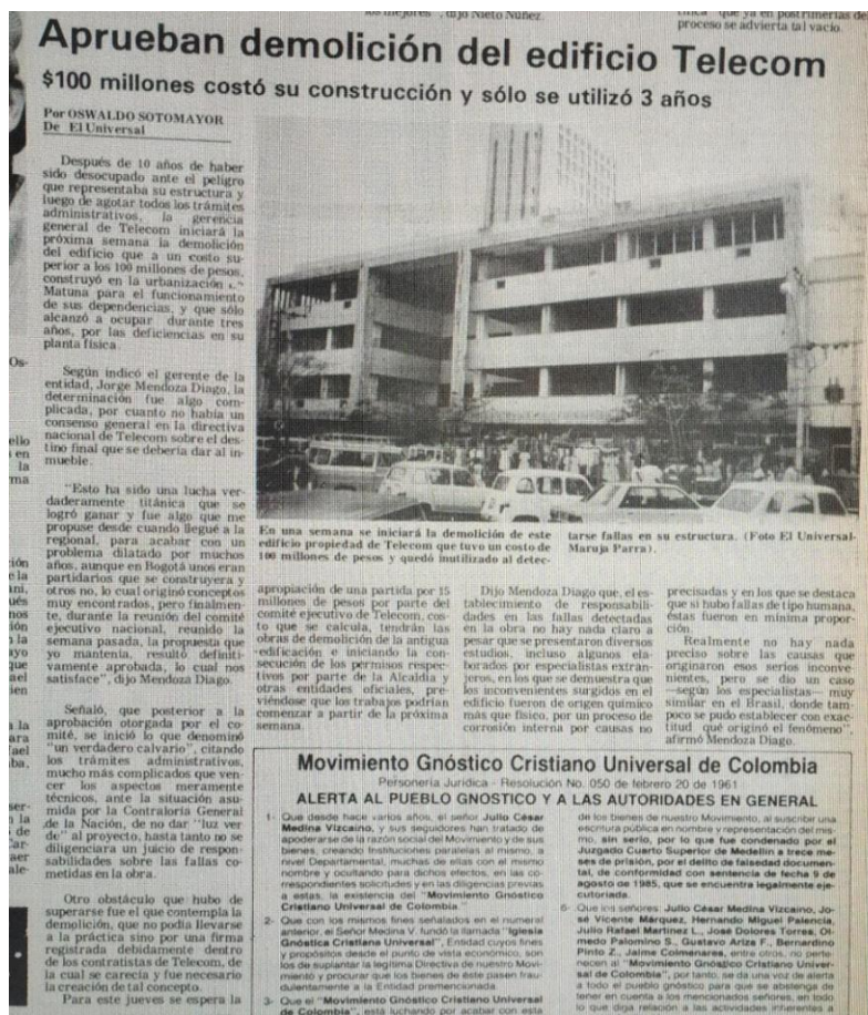
Figura 26: Demolición del edificio de Telecom en 1986
