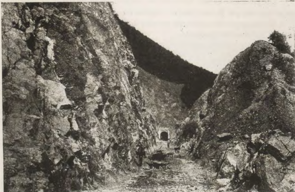
TÚNEL 6 DEL FERROCARRIL DEL CAUCA
