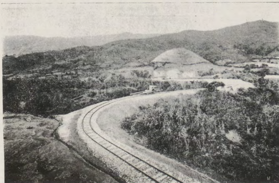
CURVA DE 23'66 METROS DE RADIO MÍNIMO Y 7 POR 100 DE PENDIENTE, EN EL TRANVÍA DE ORIENTE
