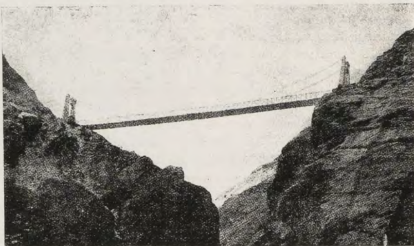
PUENTE SOBRE EL RÍO GUÁITARA, EN LA CARRETERA DE PASTO A TÚQUERRES
