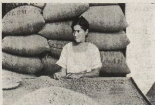
ESCOGEDORA DE CAFÉ — Después de seleccionar el café, deja caer el grano adentro de los sacos de empaque, por los cuatro buzones que tiene la mesa.
