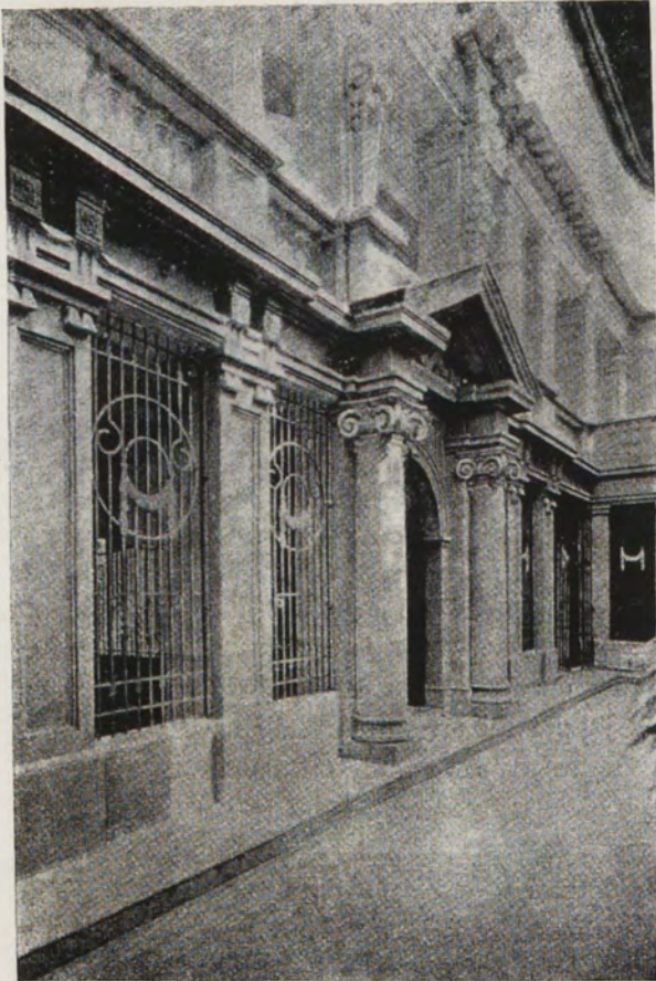
EDIFICIO DEL BANCO DE LA REPÚBLICA EN MEDELLÍN. FACHADA INTERIOR
