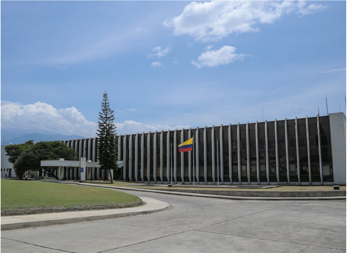
Fotografía 1. Planta de acuñación Antonio Barriga Villalba en Ibagué
