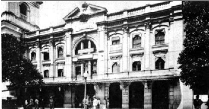
Fachada exterior del Banco de la República
