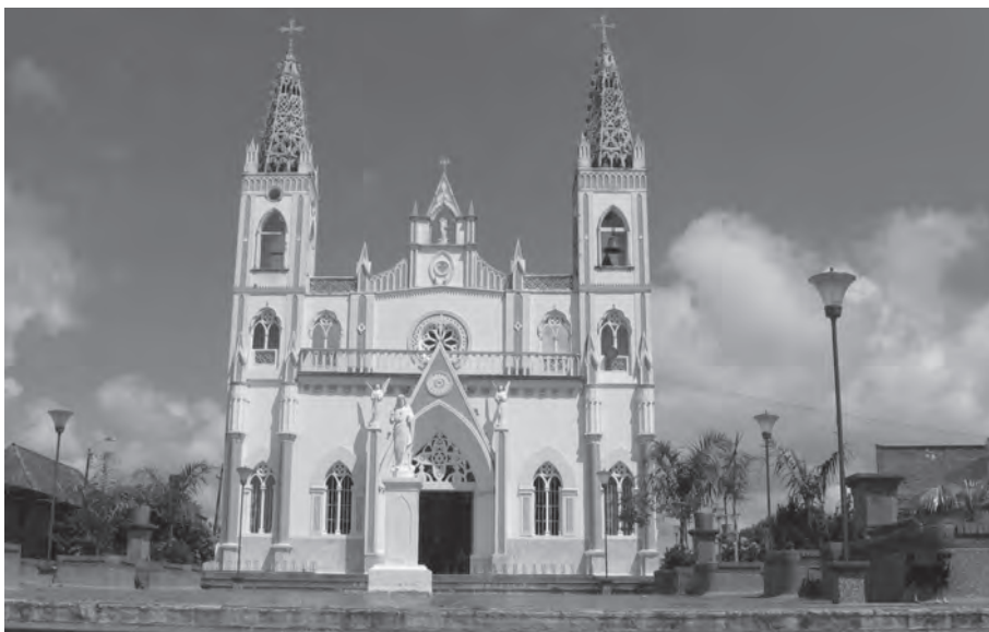
Fotos 6 y 7. Fachada e interior de la Catedral de San Jerónimo de Ayapel
